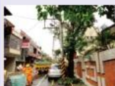
洽請台電公司鋸樹
