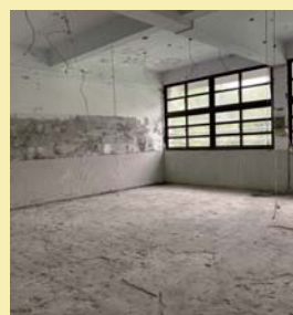
翻修中的校史室
